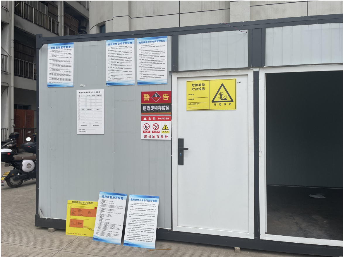
附图 2：危废暂存间
